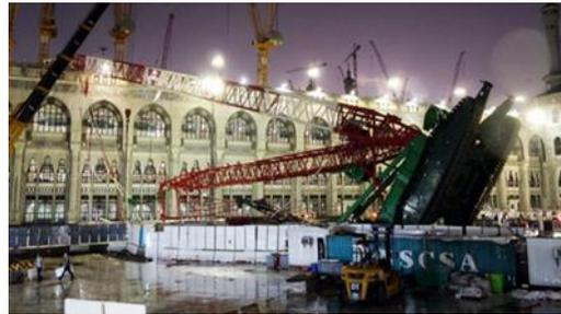
Gambar 64. *Crane* kehilangan daya angkat
